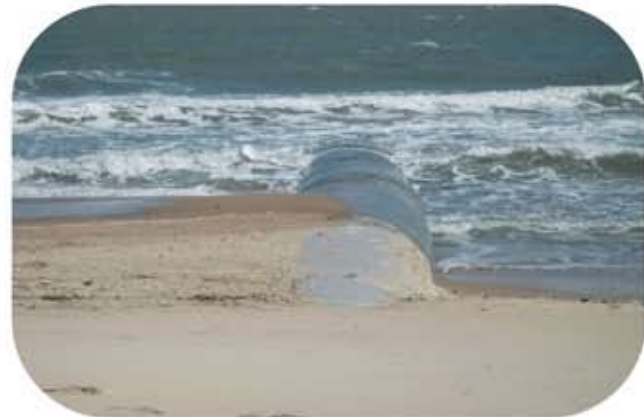
Pas de blocage du transit : les ouvrages captent les sédiments et en sont progressivement recouverts.
