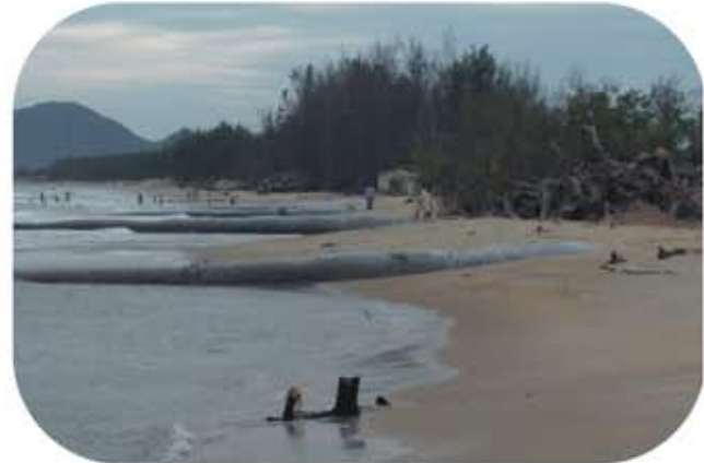
8 STABIPLAGE® conçus et posés sur site - Eté 2005
