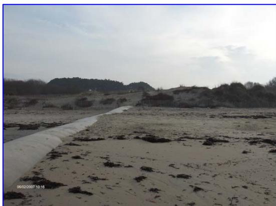
Dès le premier mois de fonctionnement, les ouvrages ont capté et accumulé un volume de sédiment significatif. Sur la photo ci-dessus, le STABIPLAGE® est recouvert de moitié par le sable accumulé : le niveau du profil de plage remonte progressivement.
