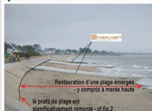
Fig.4 : Etat du site été 2007
