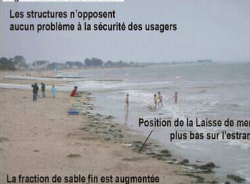
Fig.4 : Etat du site été 2007
